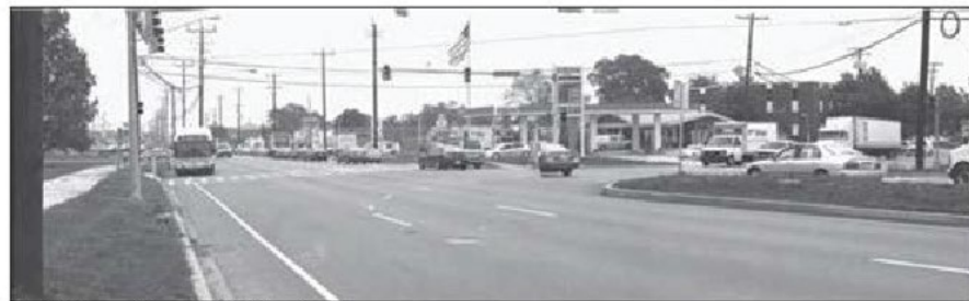
Calle Sunnyside en la US 1: existente
